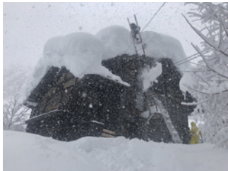
空き家作品の除雪作業
