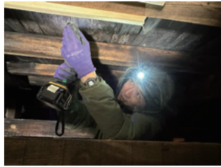
廃校作品の床下の補強作業
